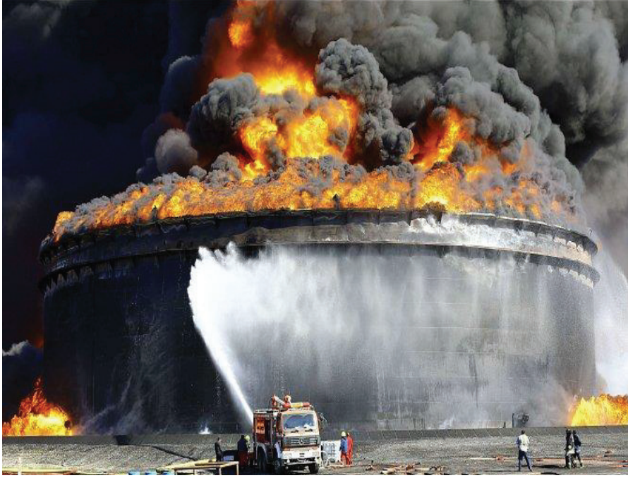
الشكل (7.4): حرق خزانات النفط بمنطقة السدرة نتيجة الاشتباكات
