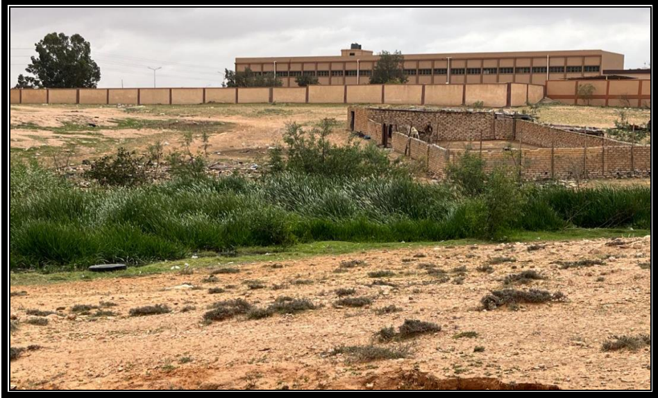
صورة (5) توضح مدى قرب مكان تجمع مياه الصرف الصحي من الحي الإسكاني بمنطقة الدراسة
